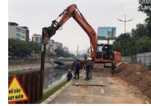
Hanoi City Yen Xa Sewerage System Project PK2 【VIETNAM】
